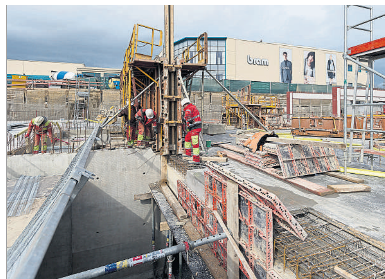
Dès août, à temps pour la braderie, le parking en rez-de-chaussée sera accessible pour la clientèle.
