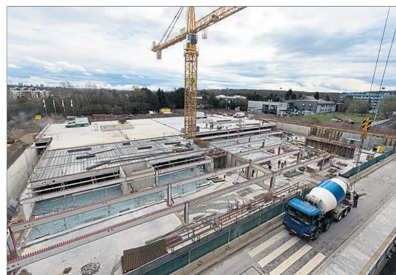
Actuellement le parking aérien à l'est du centre est en train d'être transformé en parking souterrain.
